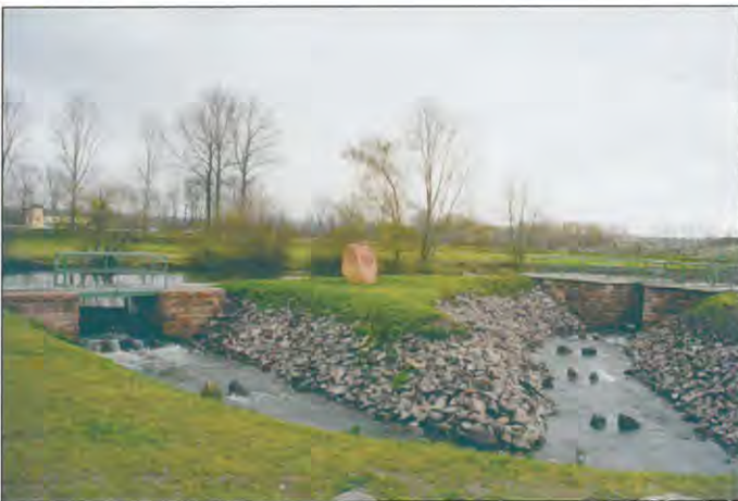
Fischaufstiegsanlage am Helmwehr in Oberröblingen
