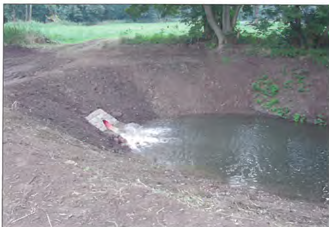
Der einst „trockene“ Altarm erhielt nach der Sanierung einen neuen Wasseranschluss
