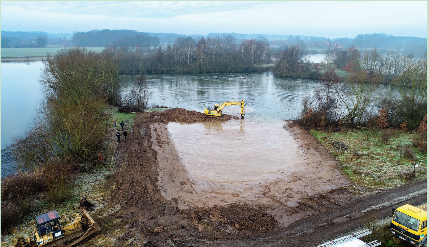
Abb. 2: An vier steilscharigen Baggerseen wurden zusätzlich zum Totholzeintrag Flachwasserzonen neu angelegt und an die Gewässer angeschlossen.
